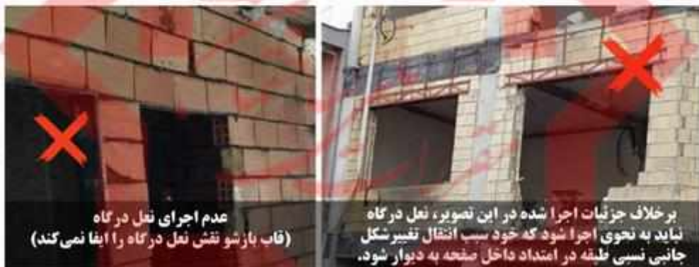
شکل پ-۷-۴ ایرادات متداول مربوط به نعل درگاه باز شوها.
